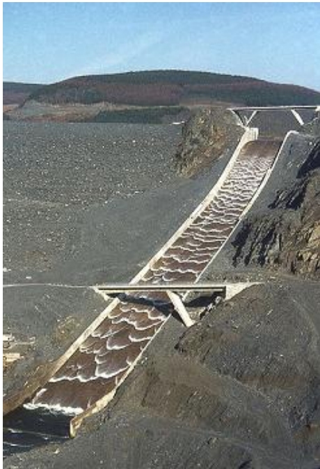
Рис. 4. Открытый бетонный водосброс большого водохранилища (плотина Ллина Брайана в Уэльсе). Над верхней частью водосброса и над его срединным участком расположены мосты.
